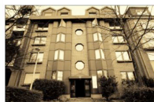
Hermann Haber (oben) und der Standort des „Stolperstein“, Rheinische Straße 12, Mülheim-Stadtmitte, Aufnahme von 2009
